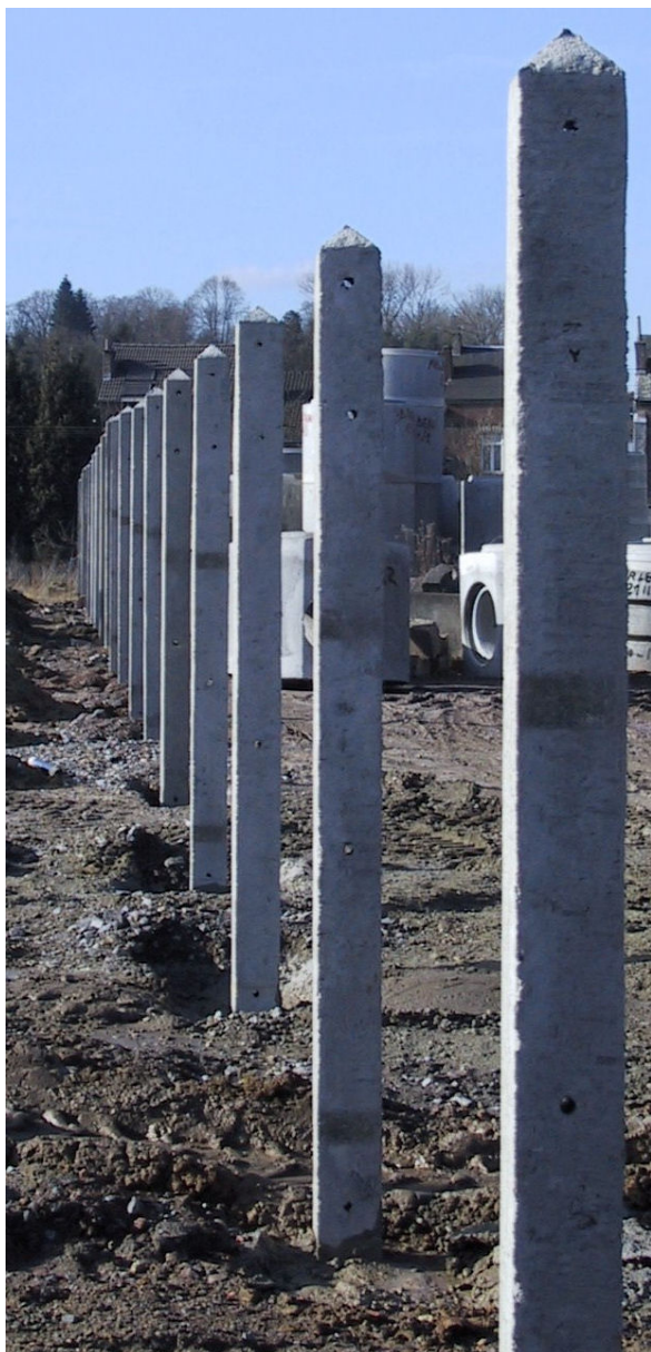
Pose de clôture – Piquet béton
