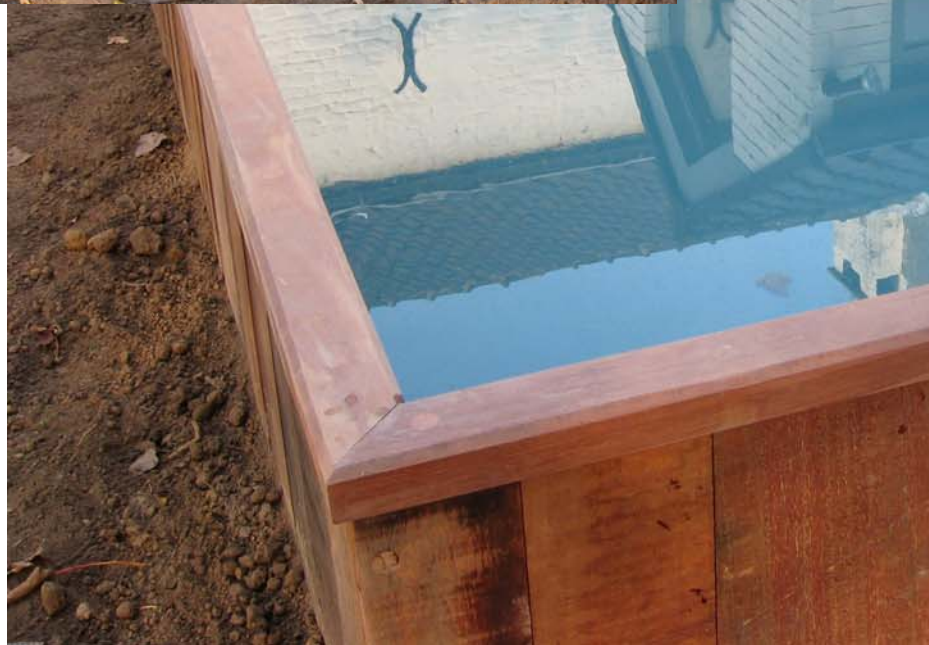
Palplanches en Azobé avec profil de finition Lattes en Azobé pour délimitation de parterres
