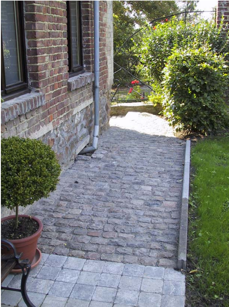
Vieux pavés Bordure en béton 100x20x6 Pose de pierres de récupération
