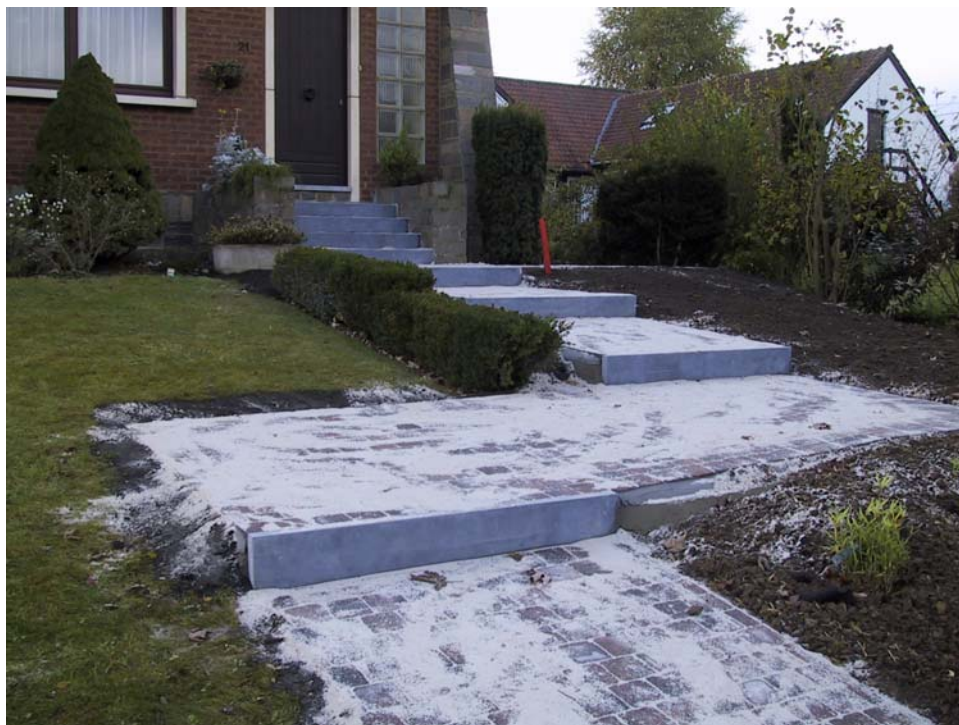
Réalisation de palier avec nez de marche en pierre bleue.
