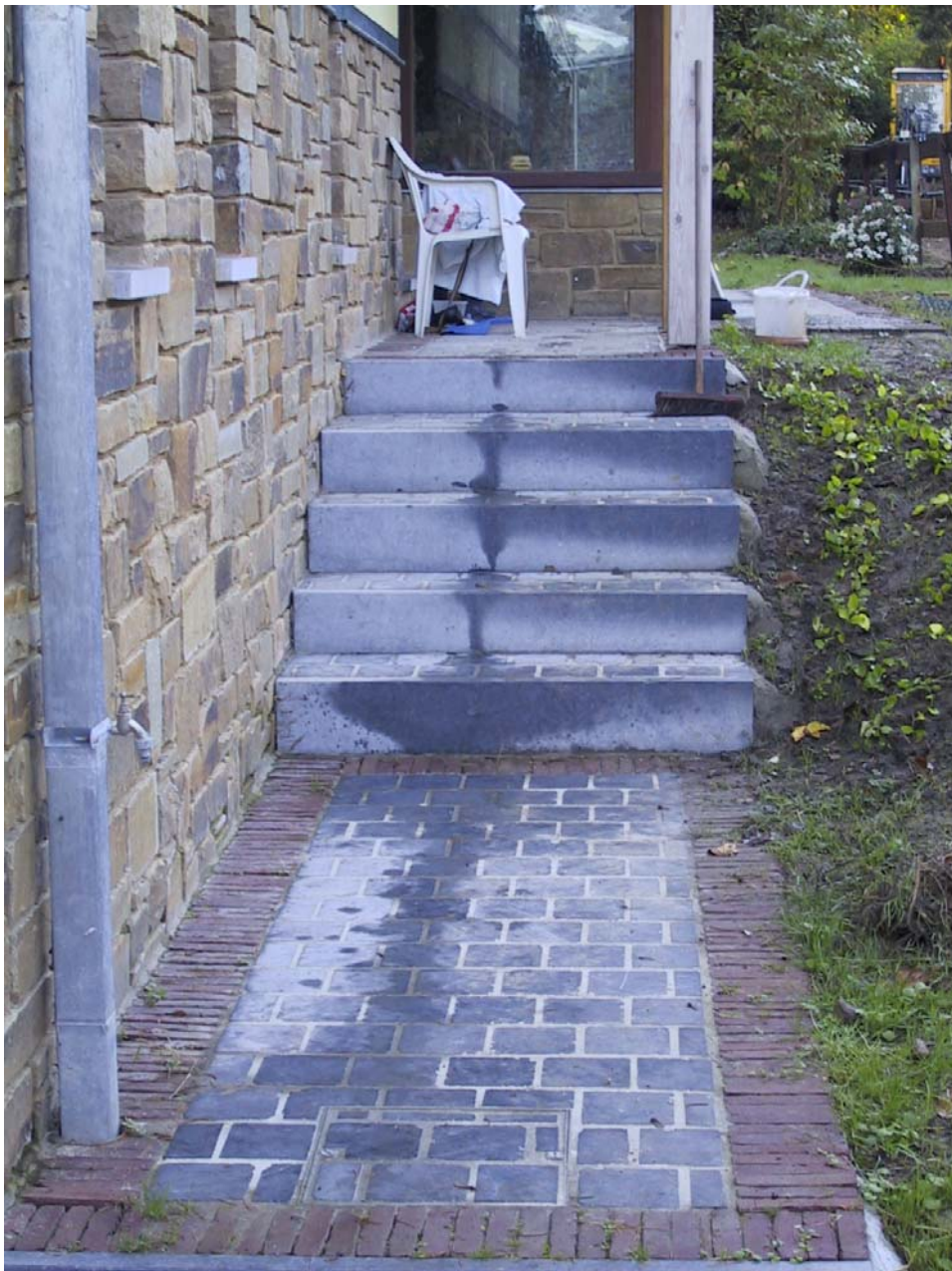
Chemin en Pierre Bleue Asiatique 15x15x2,5 Bordures en briquettes terre cuite béton 220x60x90 Contre marches Pierre Bleue Belge – Finition G220
